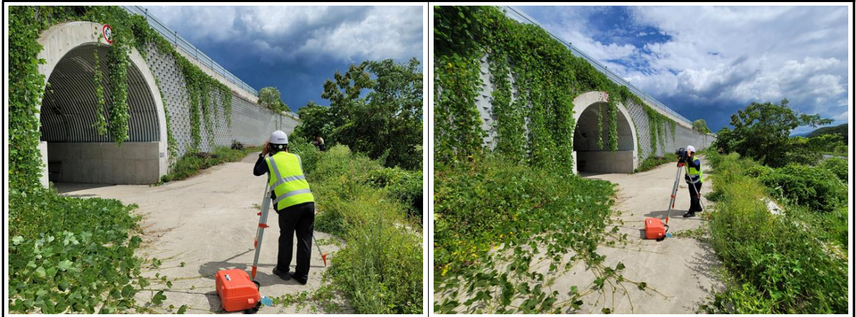
【사진 9.4.2】 측량작업 전경
