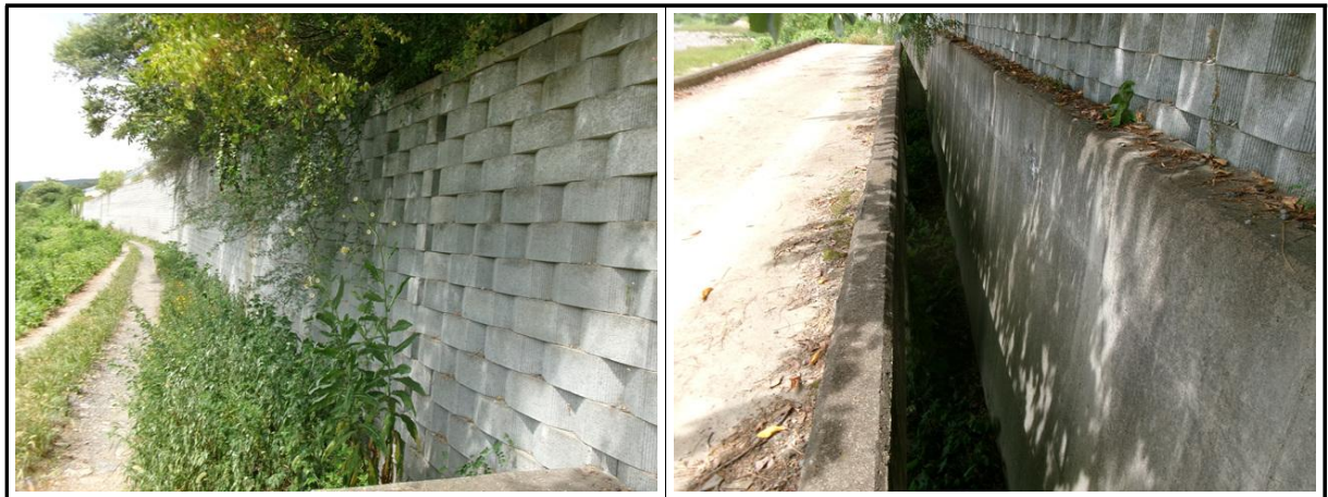
【사진 9.3.1】 지반, 기초부 전경
